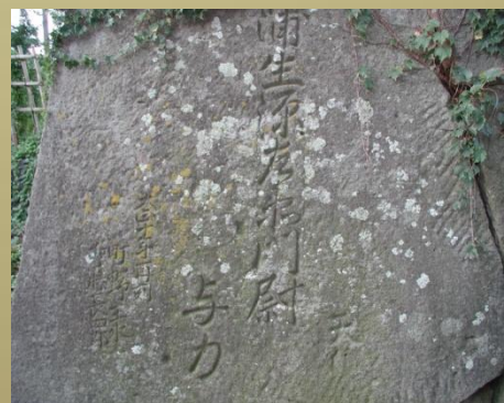
慶長年間、(1610年頃)外郭・外堀の甲賀町口にある石垣。「蒲生源左衛門尉」と彫られています。
